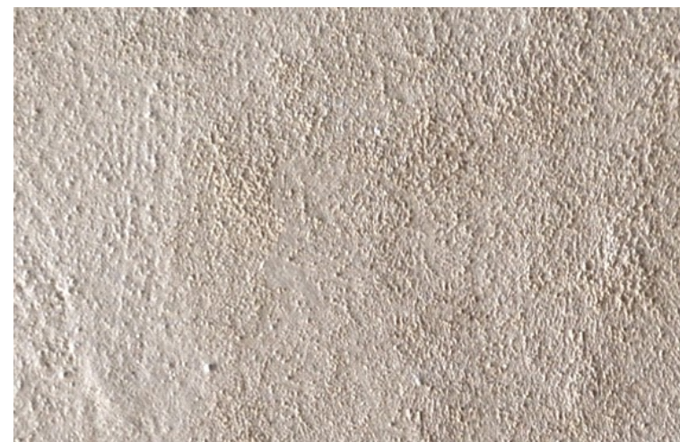
Aplicación acabado texturizado Application of Textured Finish
