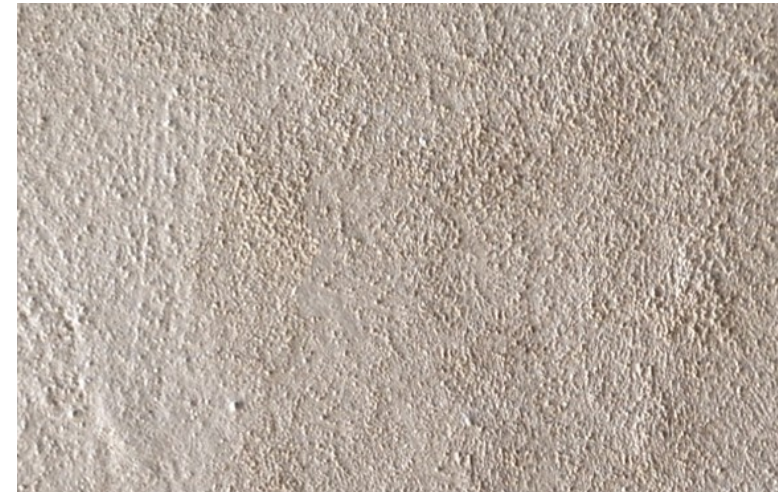
Aplicación acabado texturizado Application of Textured Finish
