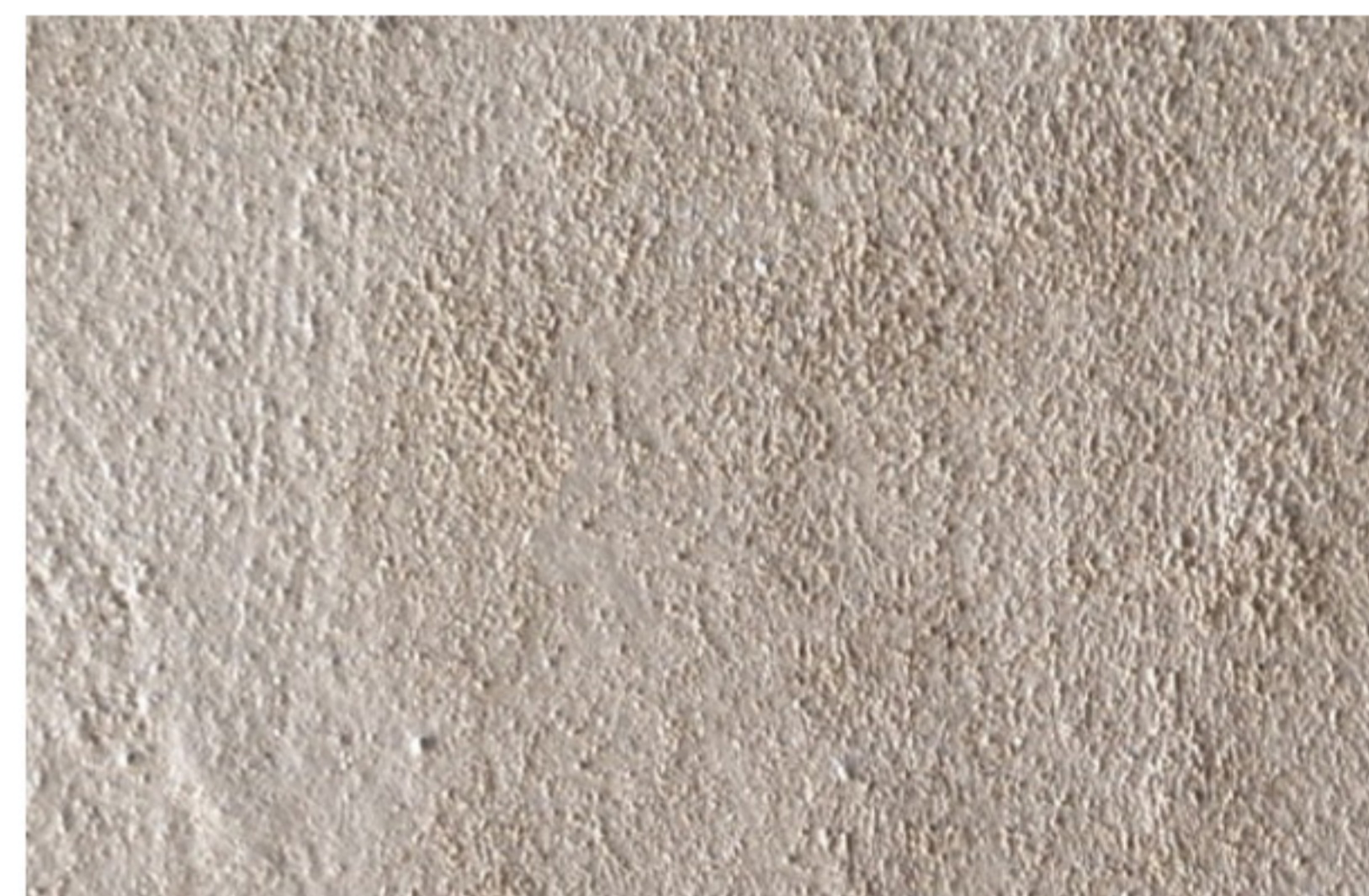
Aplicación acabado texturizado Application of Textured Finish
