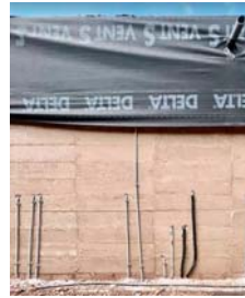
Ref.03 Instalaciones por la cara exterior del muro antes de colocar el corcho de aislamiento Installations on the exterior face of the wall before placing the insulation cork
