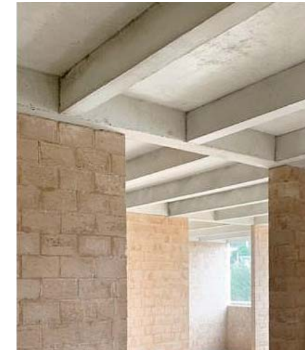
Ref.02 Forjado de hormigón Concrete slab
