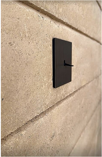
Ref. 01 Detalle de los interruptores Switches detail
